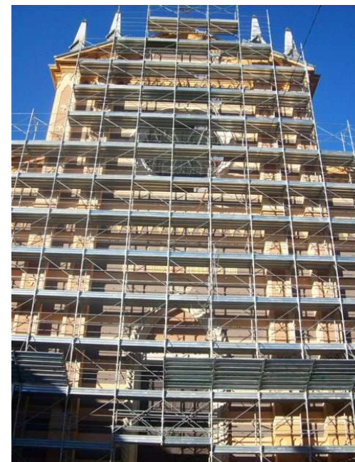
La facciata della chiesa parrocchiale con il ponteggio
